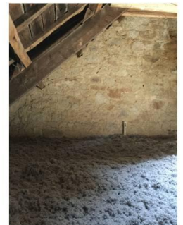
Soufflage de ouate de cellulose – 35 cm d'épaisseur après tassement
