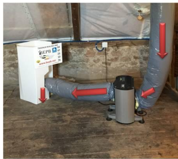
VPH – Ventilation Positive de l'Habitat hygrorégulée Prise d'air par l'extérieur, tempéré dans la VPH, diffusé par le plafond
